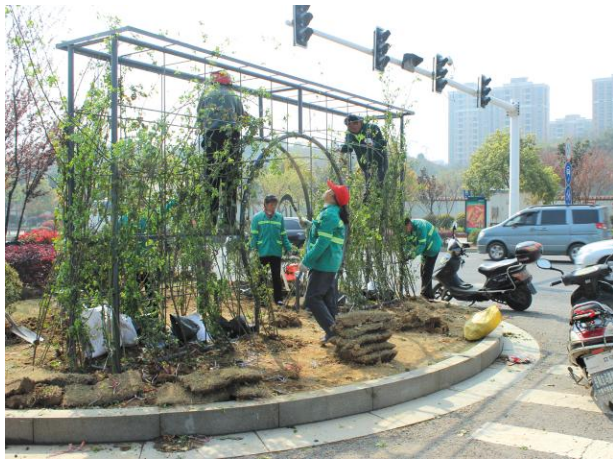
搭建钢结构造型框架
